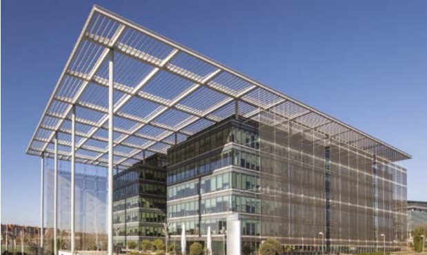
Immeuble de bureaux El Portico, Calle Mahonia 2, Madrid – Espagne
