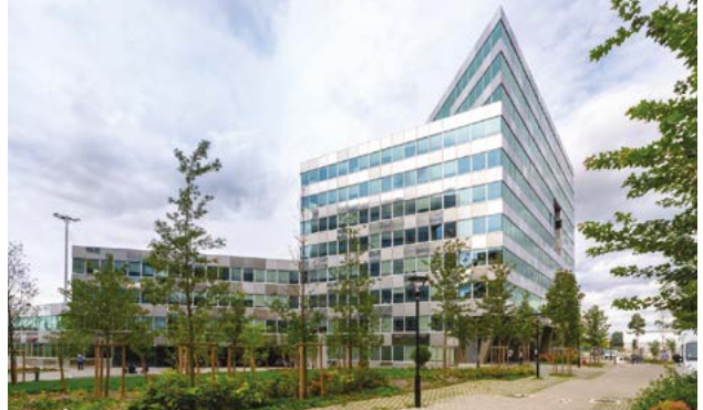
Immeuble de bureaux, Euronantes, 6-8 rue Nathalie Lemel/9 rue Nina Simone, Nantes – France
